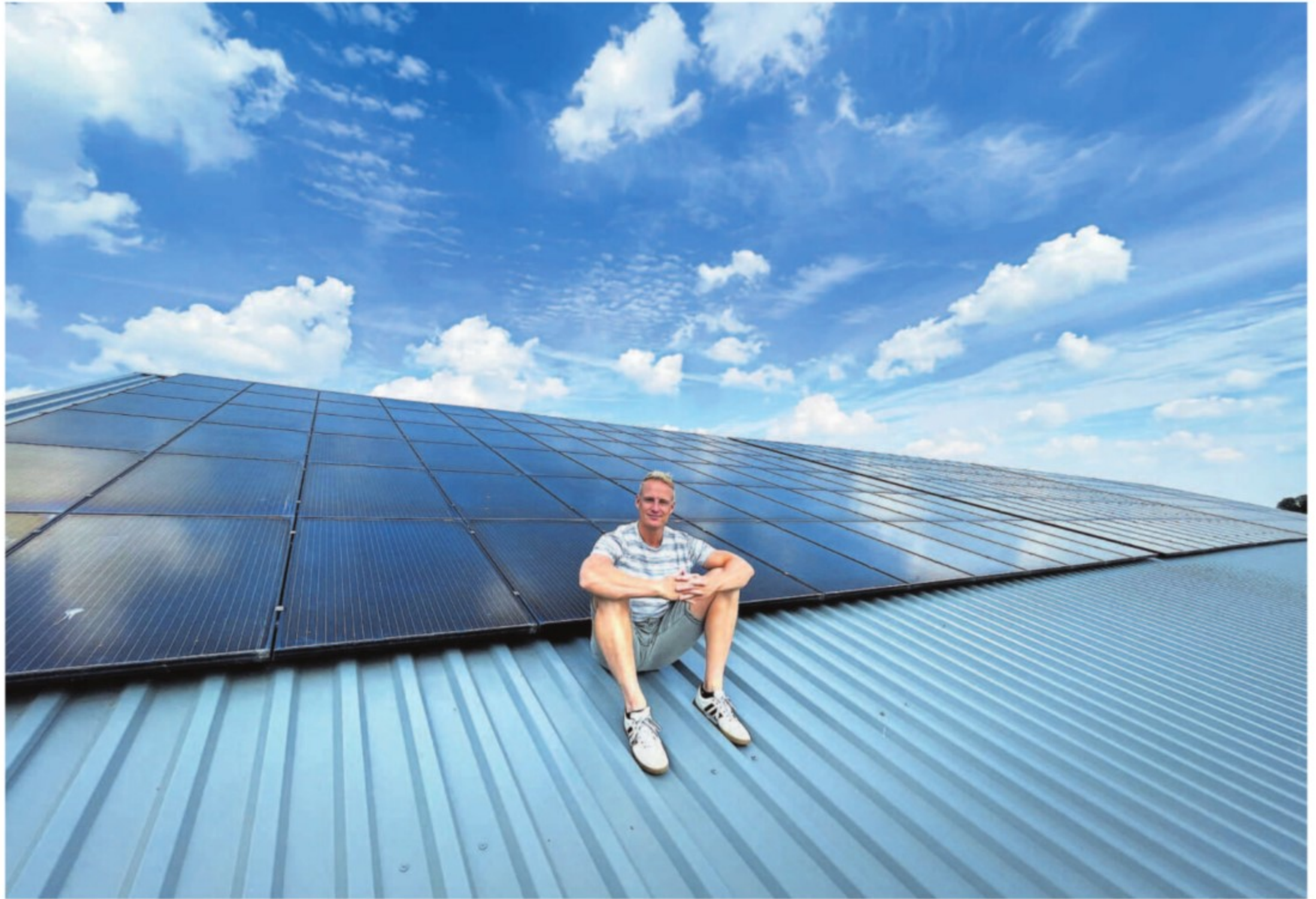
Klaas Bijlsma van de Bildtse Energiecoöperatie op een dak met zonnepanelen in Nij Altoenae. FOTO CATRINUS VAN DER VEEN
